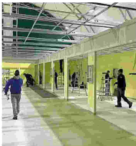
Il tendone San Raffaele, la terapia intensiva in costruzione
